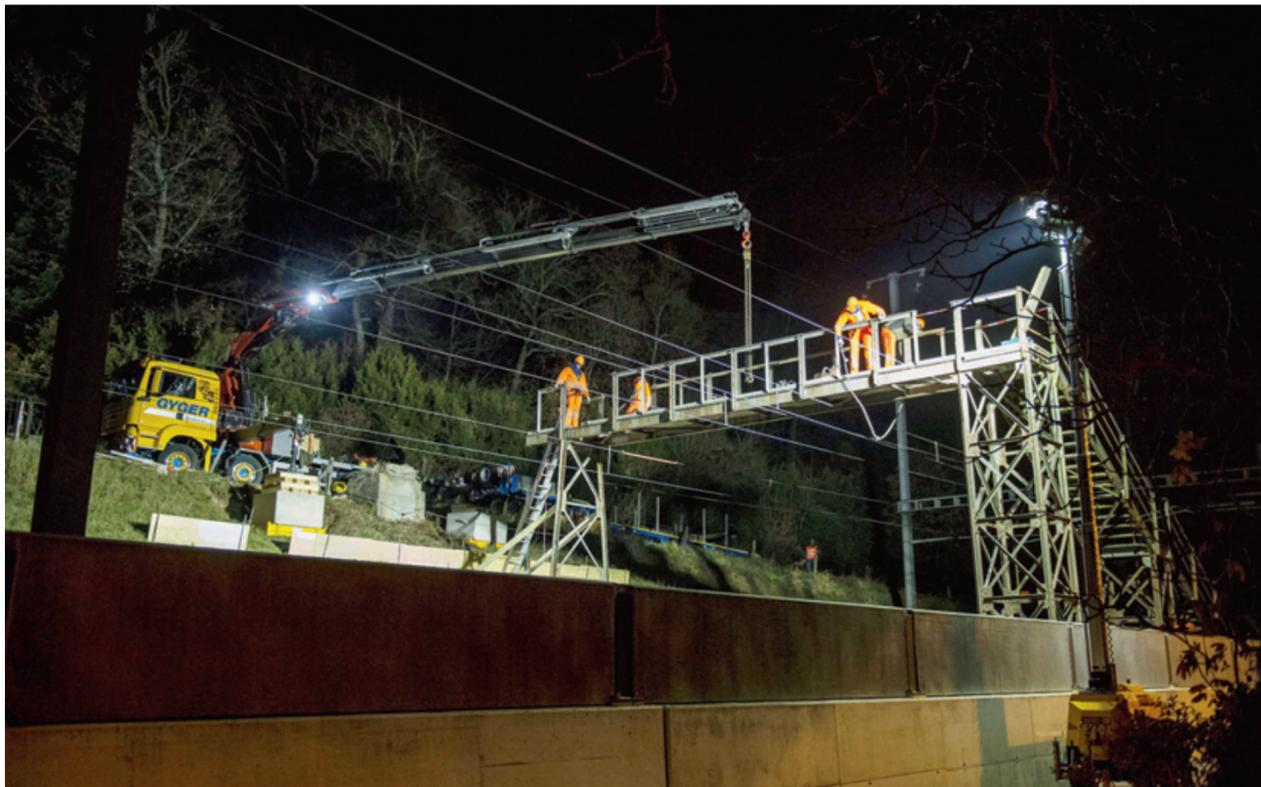
La passerelle doit être soutenue par la grue avant que les ouvriers ne scient ses extrémités pour la détacher. LUCAS VUITEL
